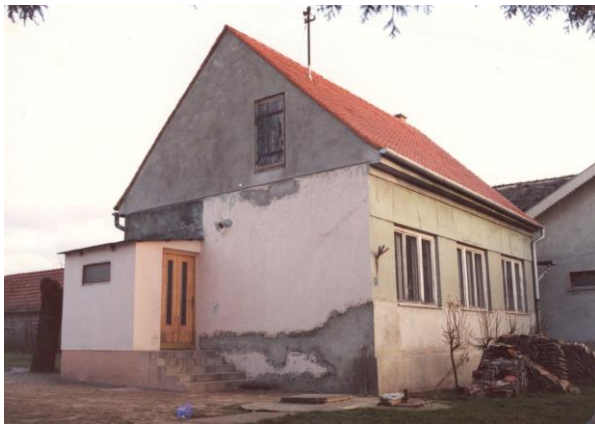
Školska zgrada prije adaptacije 2004. godine.
