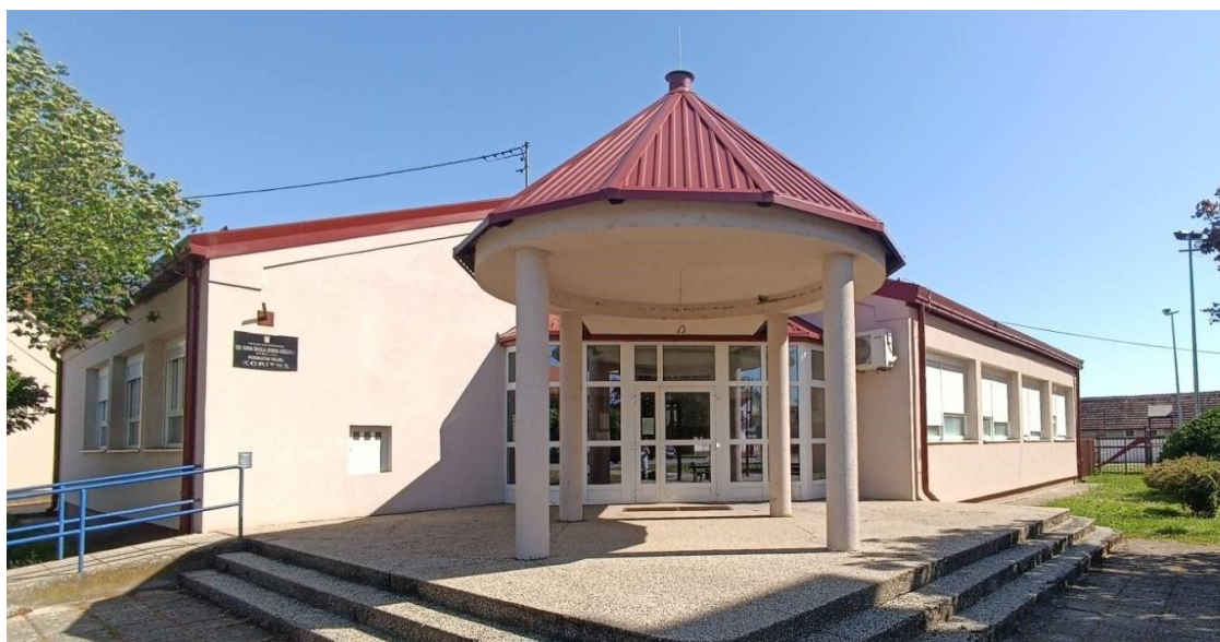
Školska zgrada u Koritni izgrađena 1996. godine.
